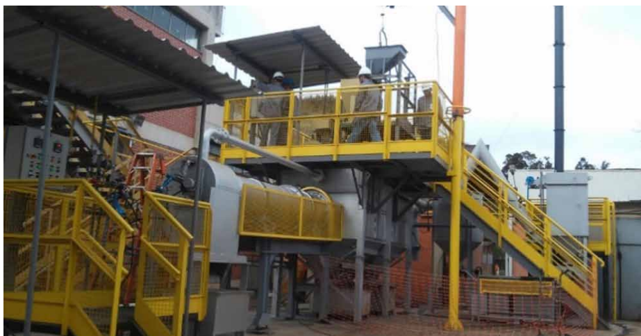
Fig 5: planta piloto, forno Waelz, Votorantim Metais
