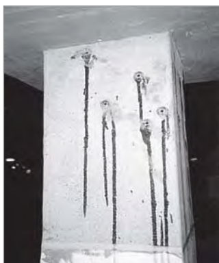
(b) Injeção de Resina Epóxi nas Fissuras
