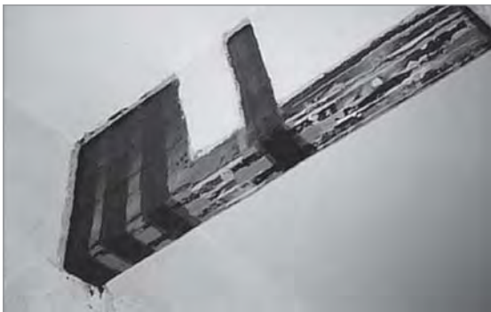
(e) Vista Frontal da Obra de Reforço
