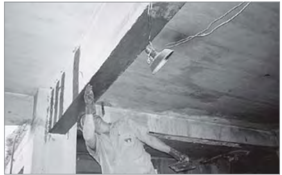
(b) Execução do Reforço à Flexão da Viga de Concreto
