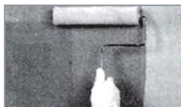
(a) Aplicação de Primer na Superfície de Concreto
