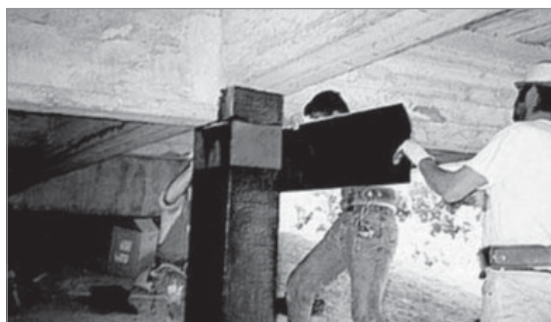
Figura 9 – Exemplos de Aplicação de Materiais Compósitos de Resina e Fibras no Reforço de Elementos Estruturais de Concreto. Disponível em: < http://www.shf.ac.uk/uni/projects/tmrnet/galleries >. Acesso em: nov.2002
