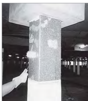
(d) Aplicação de Resina Epóxi Primer
