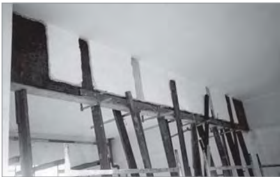
(c) Execução do Escoramento do Reforço da Viga para Cura da Cola
