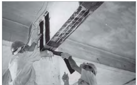
(d) Execução do Reforço ao Cortante da Viga de Concreto
