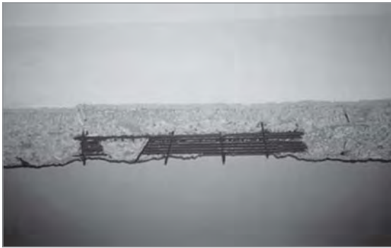
(a) Recuperação da Armadura com Inibidor de Corrosão
