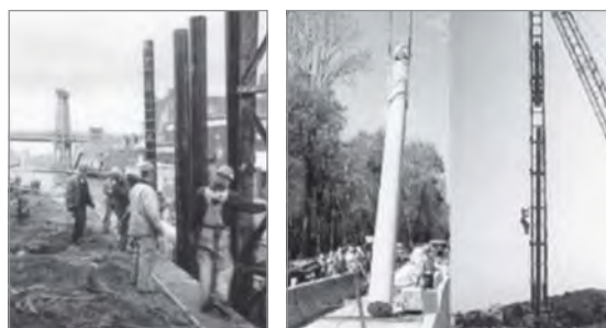
Figura 14 – Detalhe de Estacas de Tubos de Compósitos de Resina e Fibras de Vidro. Disponível em: < http://www.ecn.purdue.edu/ECT/Civil/cp40.htm >. Acesso em: jul. 2003
