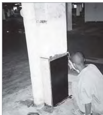
(g) Colocação da Primeira Folha de Fibras de Carbono Sobre a Superfície do Concreto
