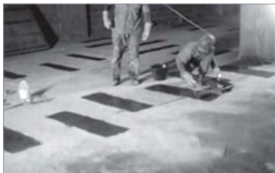
(b) Reforço Unidirecional na Região de Momentos Fletores Negativos
