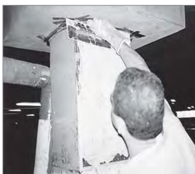
(e) Aplicação de Resina Epóxi para Regularização da Superfície
