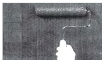
(c) Aplicação da Cola de Resina Epóxi na Superfície de Concreto
