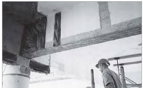
(f) Vista Após Aplicação de Argamassa Protetora e Pintura
