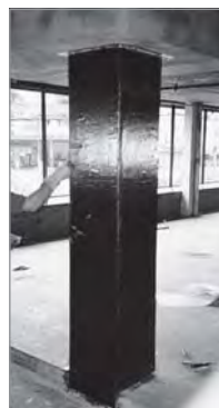
(i) Vista Completa do Pilar Após a Segunda Camada de Reforço
