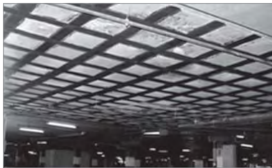
(a) Reforço Bidirecional na Região de Momentos Fletores Positivos
