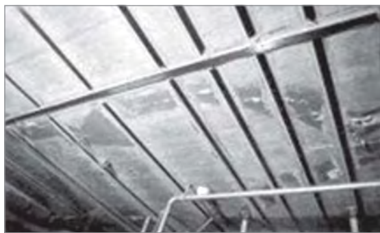
Figura 10 – Exemplo de Aplicação de Lâminas de Compósitos de Resina e Fibras de Carbono no Reforço de Lajes de Concreto. Disponível em: < http://www.ecn.purdue.edu/ECT/Civil/cfrp.htm >. Acesso em: jul. 2003
