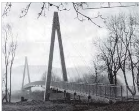
Figura 21 – Vista geral da Passarela Aberfeldy, Escócia, Reino Unido (STRUCTURAL ENGINEERING INTERNATIONAL, 1994)
