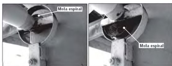
Figura 9 – Mola espiral usada em portas basculantes
